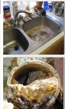
L'installation d'un séparateur de graisses permet le retrait à la source d'huiles et graisses évitant ainsi l'obstruction et la détérioration les équipements et réseaux d'assainissement. Nous recommandons son application notamment en:
